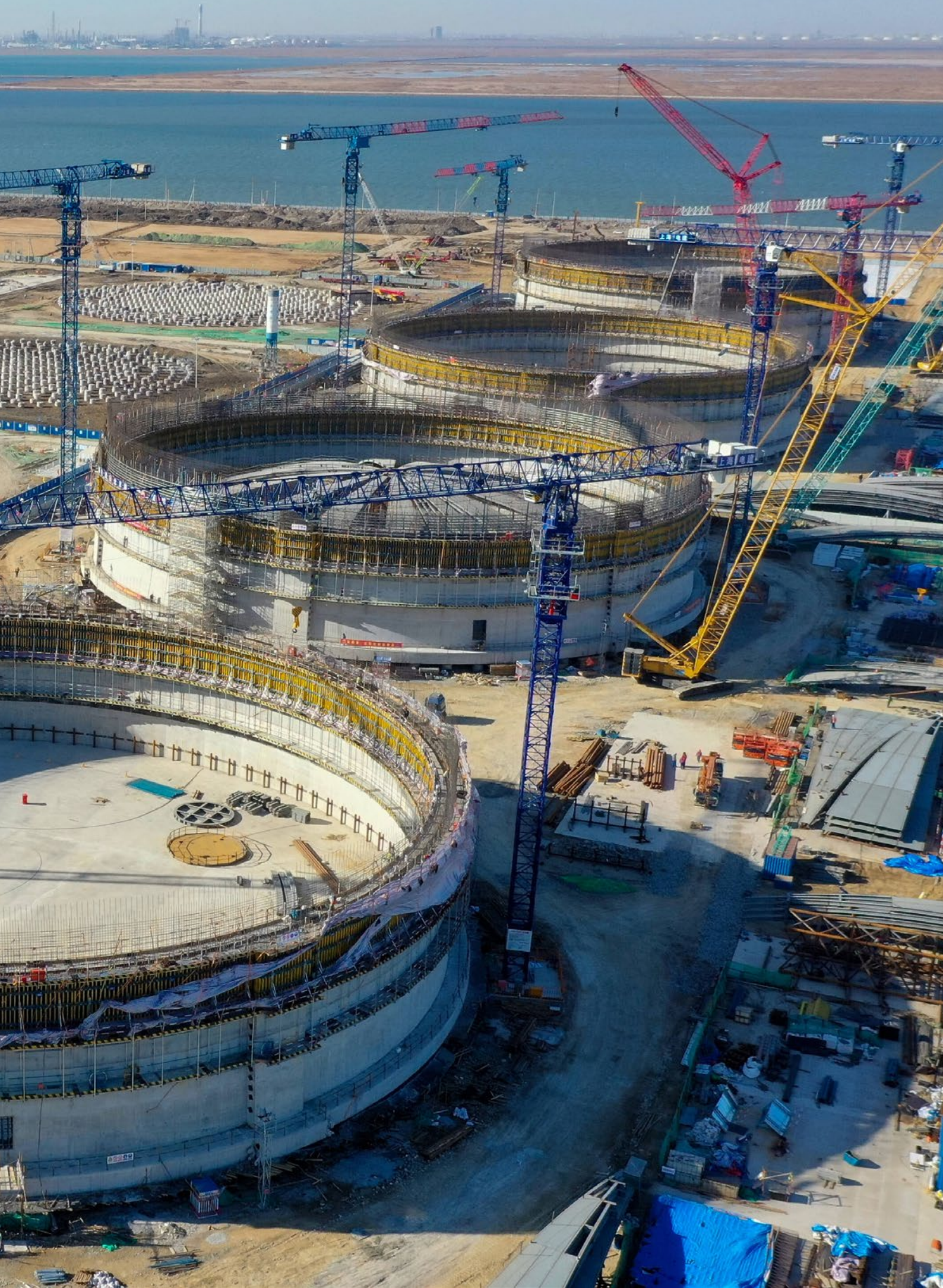
Baustelle eines von Beijing Gas betriebenen Terminals für verflüssigtes Erdgas (LNG)
