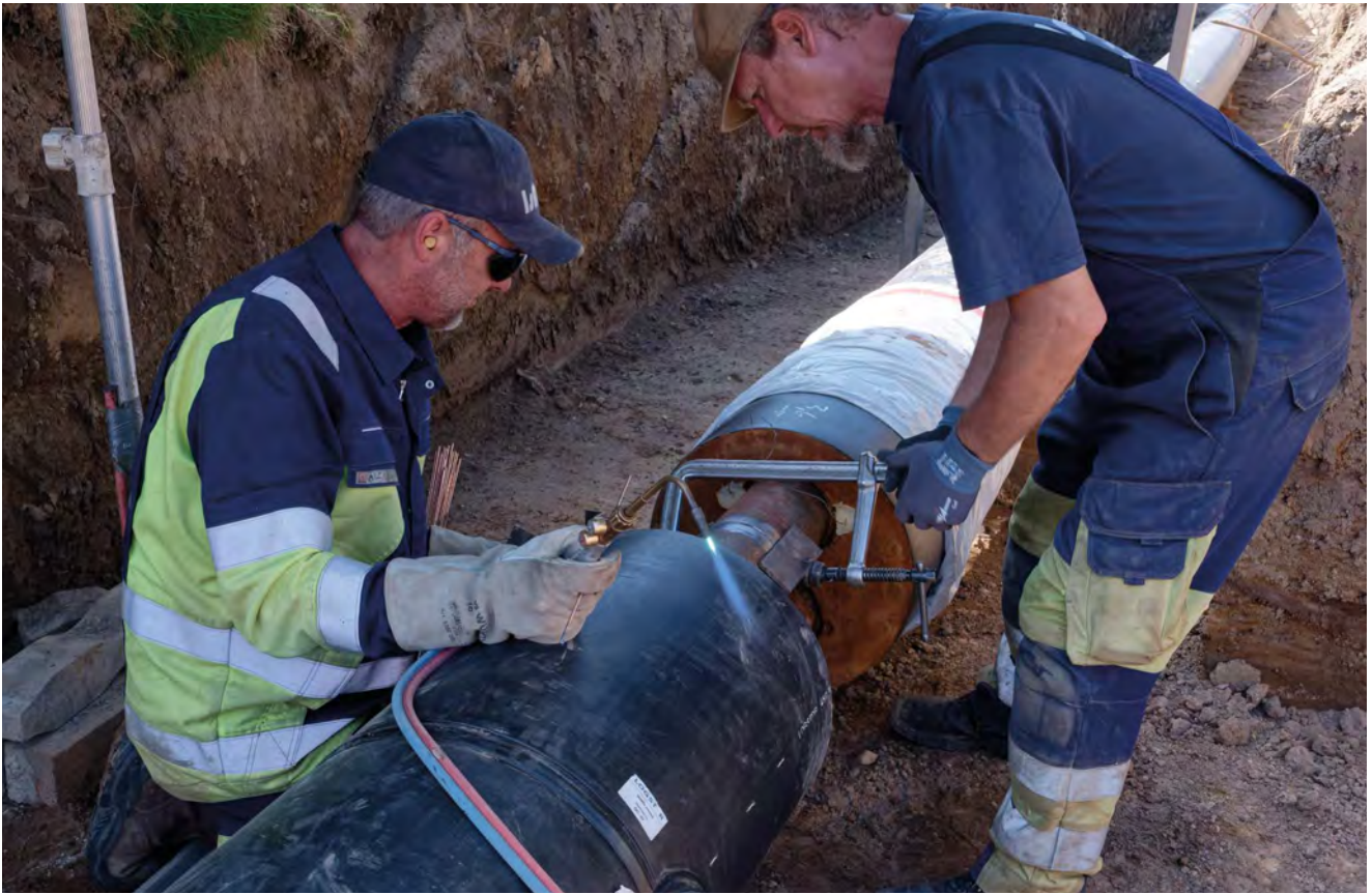
Hürup, Schleswig-Holstein 2023: Verlegung von Rohren für das Nahwärmenetz in Hürup Foto: Stephan Röhl
