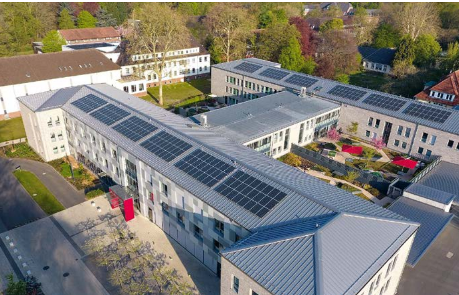
Solarstromanlage auf dem Dach der LWL-Klinik Münster.
