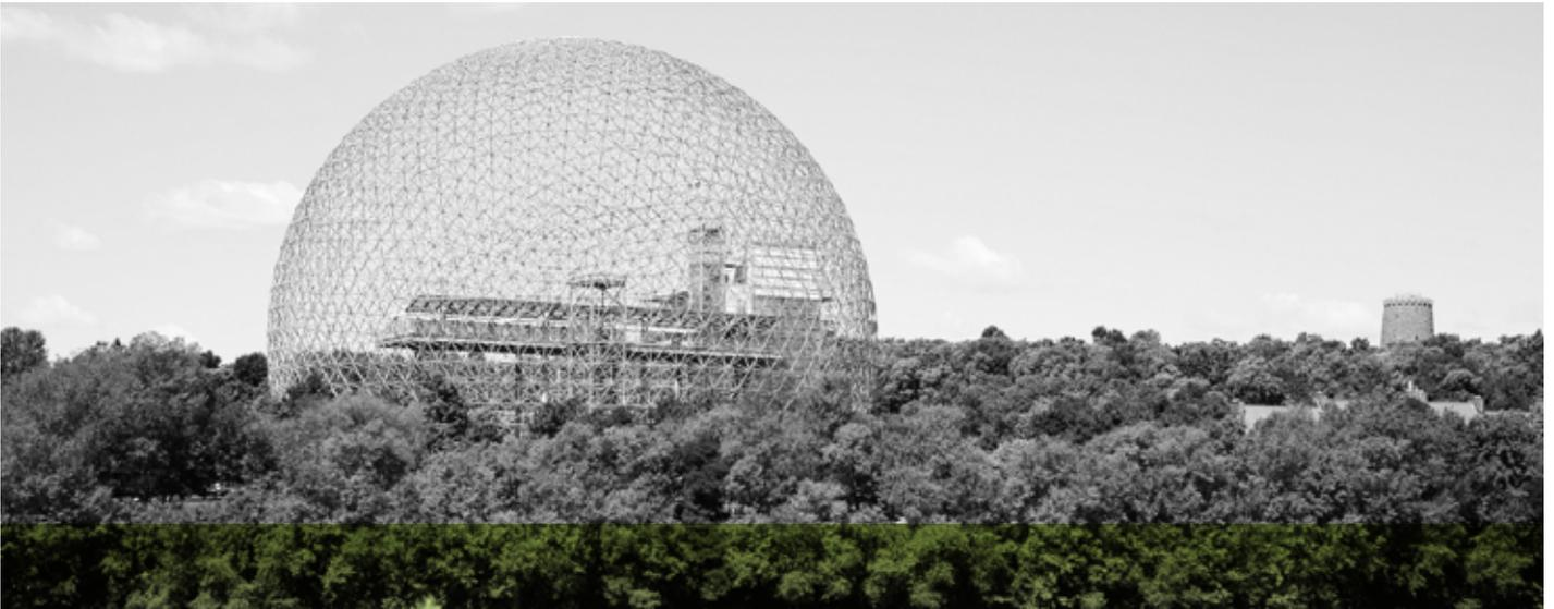
Die Biosphäre, die Buckminster Fuller 1967 in Montreal errichtete, ist eine geodätische Kugel aus einem Netzwerk von Dreiecken. Damit war es möglich, einen Dom auf einfachste Weise, aber mit festen Strukturen zu bauen, denn die Dreieckstruktur verteilt das Gewicht gleichmäßig über den Baukörper. Das einfache Design hat viele Vorteile: Erdbebensicherheit, Schallverteilung, Luftzirkulation, konstante Sonneneinstrahlung.
