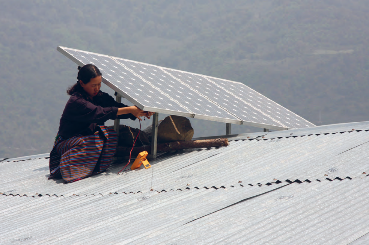
Eine Frau installiert Solar-Paneele auf einem Dach in Bhutan. (CC BY-NC-ND 2.0 Asian Development Bank – flickr)
